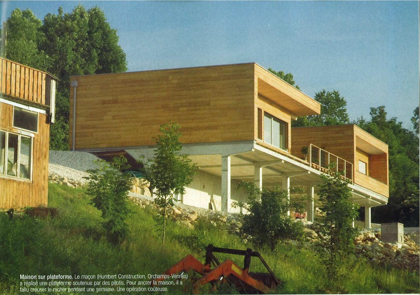
**Maison sur plateforme.** Le maçon (Humbert Construction, Orchamps-Vennes) a réalisé une plateforme soutenue par des pilotis. Pour ancrer la maison, il a fallu creuser le rocher pendant une semaine. Une opération coûteuse.
