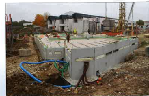
Chantier de la Maison des énergies
